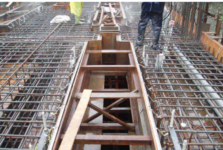
基礎錨定板安裝
