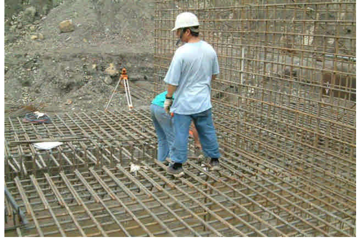
基礎錨定板安裝
