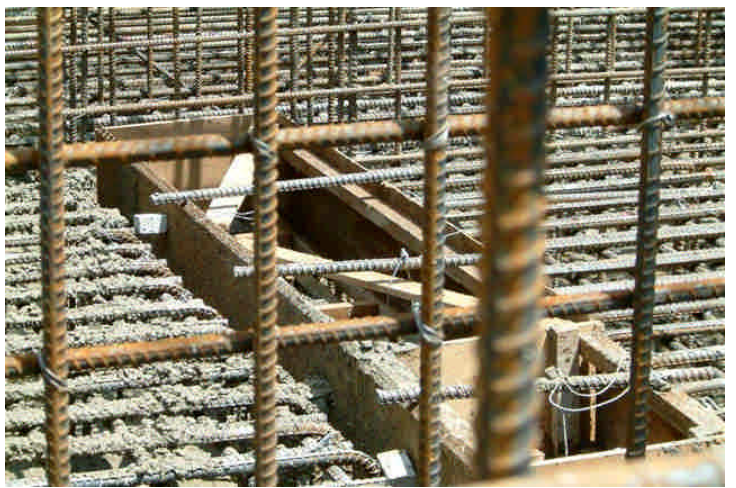
基礎錨定板安裝
