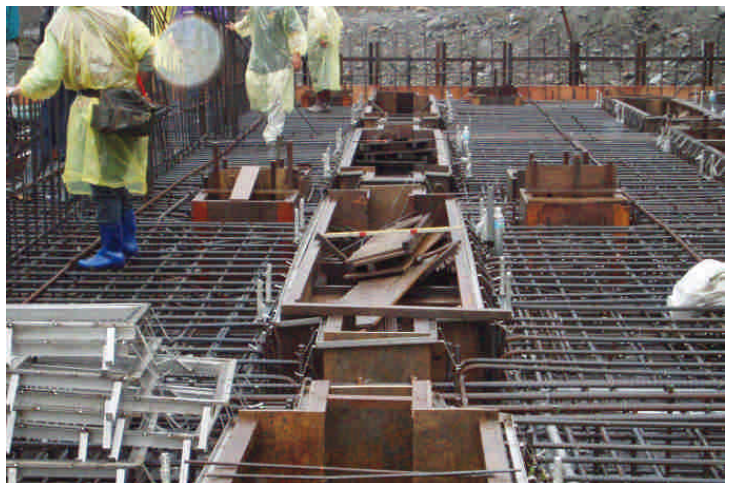
基礎錨定板安裝
