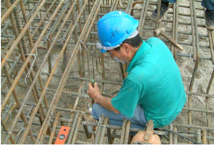
基礎錨定板安裝
