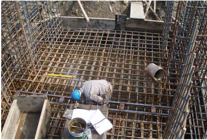
基礎錨定板安裝
