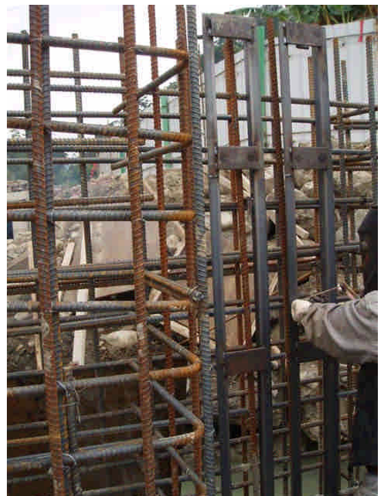
基礎錨定板安裝
