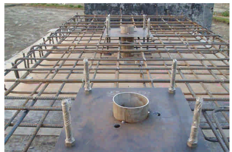
基礎錨定板安裝
