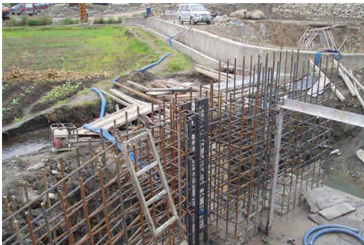
基礎錨定板安裝
