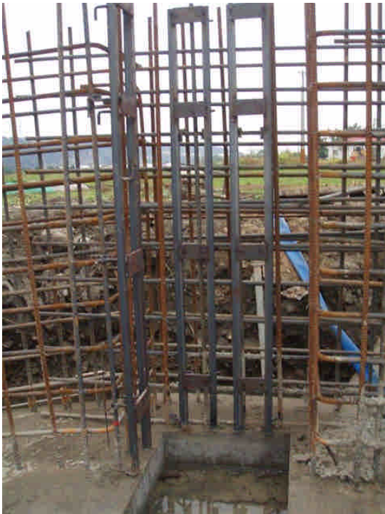
基礎錨定板安裝
