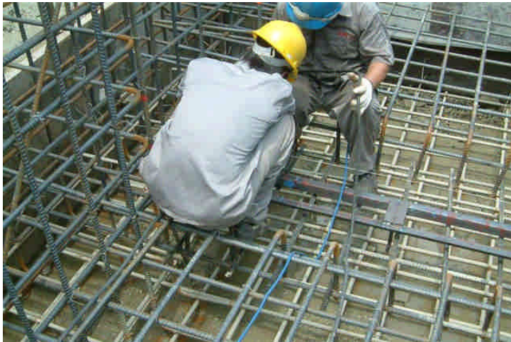
基礎錨定板安裝
