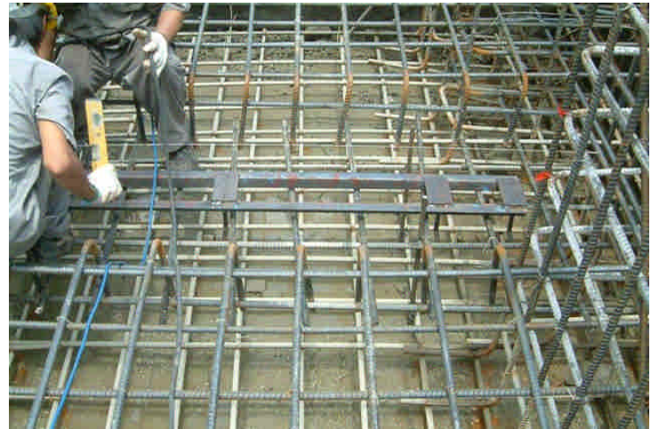
基礎錨定板安裝
