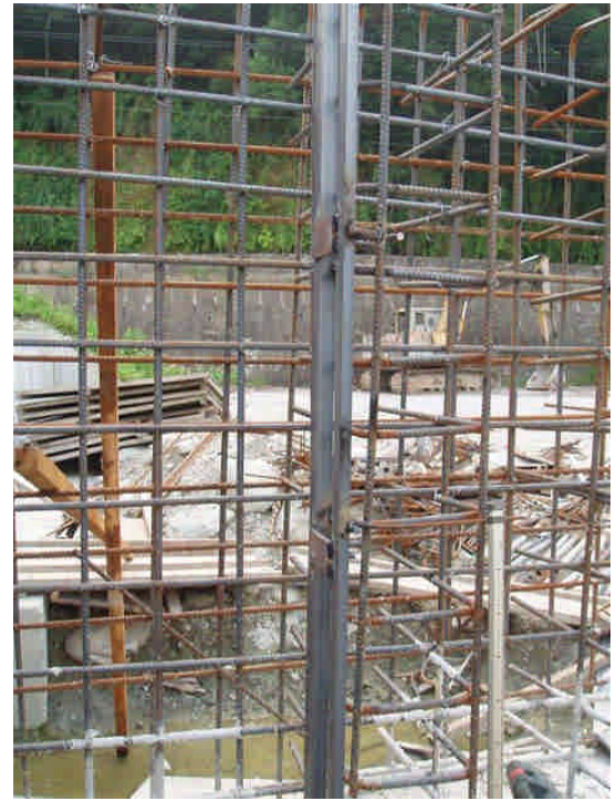
基礎錨定板安裝
