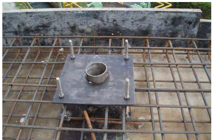
基礎錨定板安裝
