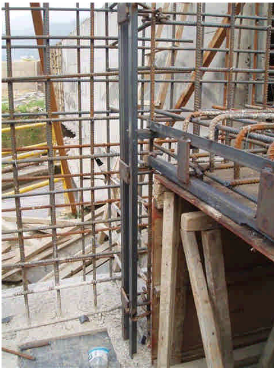
基礎錨定板安裝
