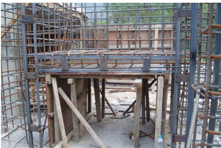
基礎錨定板安裝
