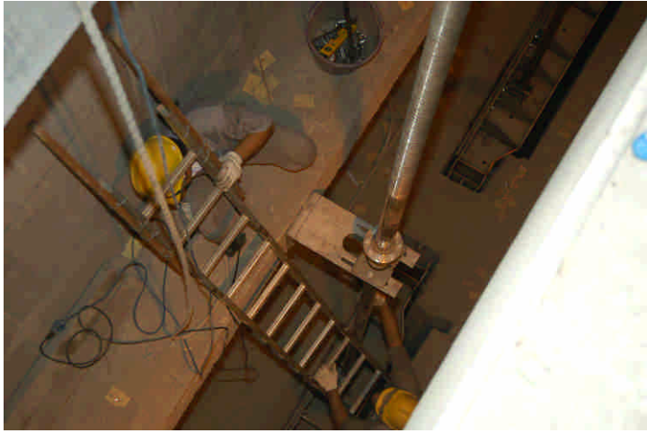
閘門吊桿安裝
