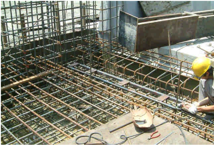
基礎錨定板安裝
