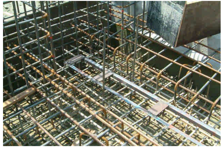
基礎錨定板安裝
