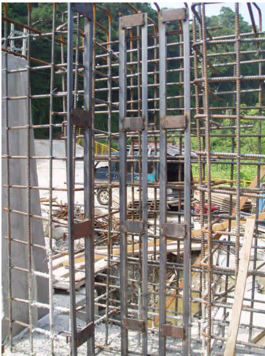
基礎錨定板安裝
