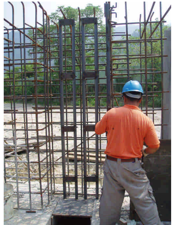
基礎錨定板安裝
