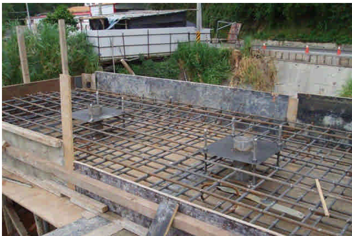
基礎錨定板安裝
