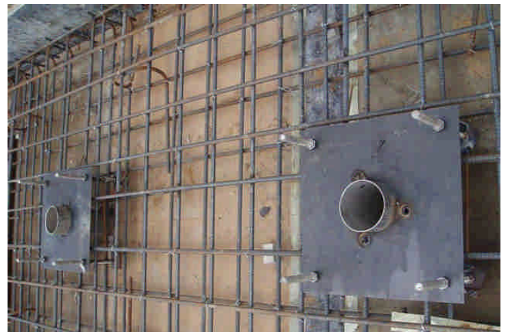
基礎錨定板安裝
